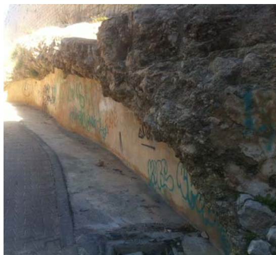
18 y 19 Flanco del baluarte de santa Lucía. Descalce de peña y cableado sobre restos de habitaciones púnicas
