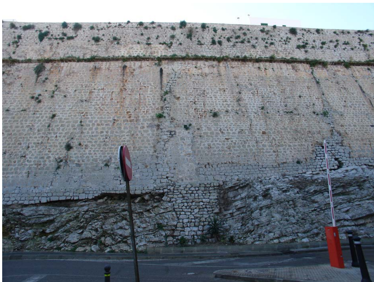
01. Zonas muy degradadas del paramento de la cortina anexa a los baluartes de San Juan y San Pedro y zonas descalzadas y hueco basamento de roca tapado con mampostería bajo la línea de rasante histórica.
