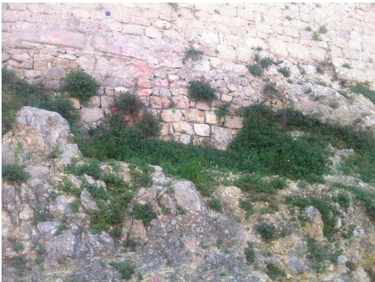
12y 13. Cara del baluarte de santa Lucía. Detalle de huecos tapados y peña descalzada bajo las fábricas
