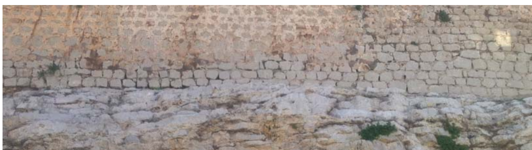
07. falta de rejuntado en basamento
