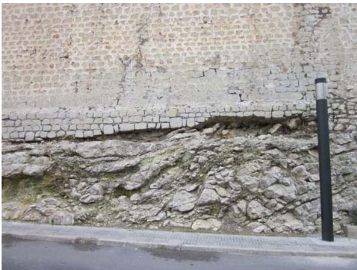
05. Cortina S. Pedro- S. Juan. descalce de basamento por degradación de roca
