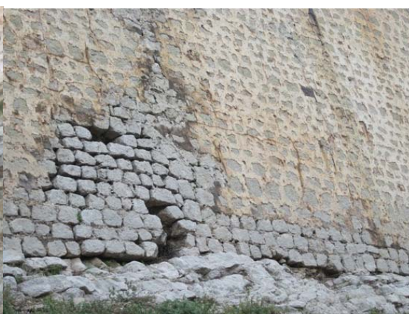
03. Detalle degradación grave paramento
