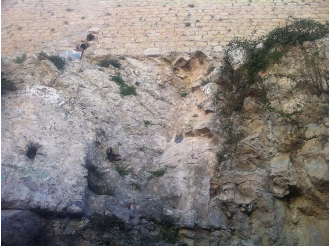
12. Cara del baluarte de santa Lucía. Descalce por desaparición base de roca y restos de conducciones de saneamiento 14 Cara del baluarte de santa Lucía. Zona de peña fracturada y descalzada
