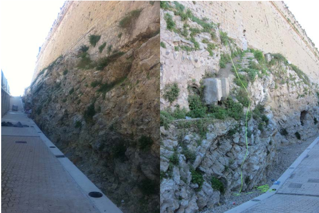
08 Cara del baluarte de santa Lucía. Descalces, degradaciones de peña y elementos disonantes.
