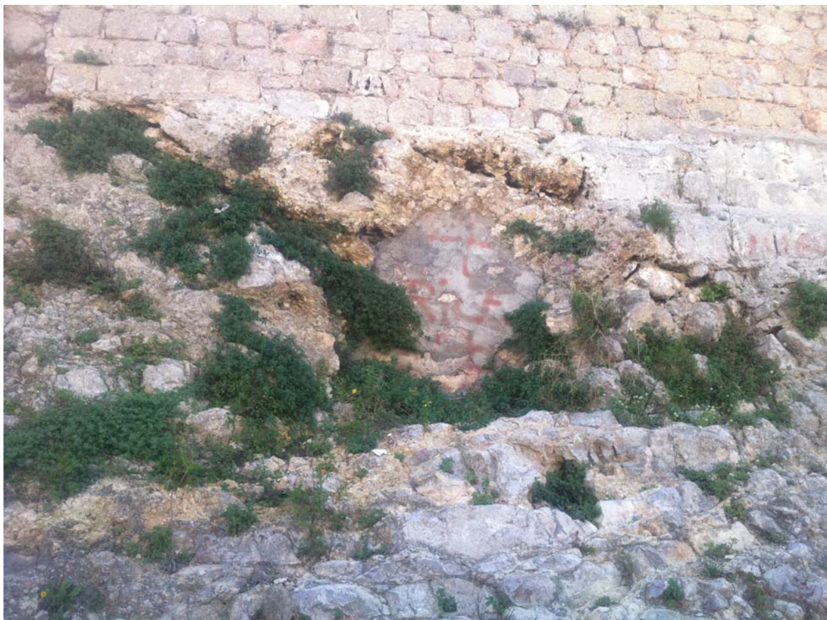
12y 13. Cara del baluarte de santa Lucía. Detalle de huecos tapados y peña descalzada bajo las fábricas
