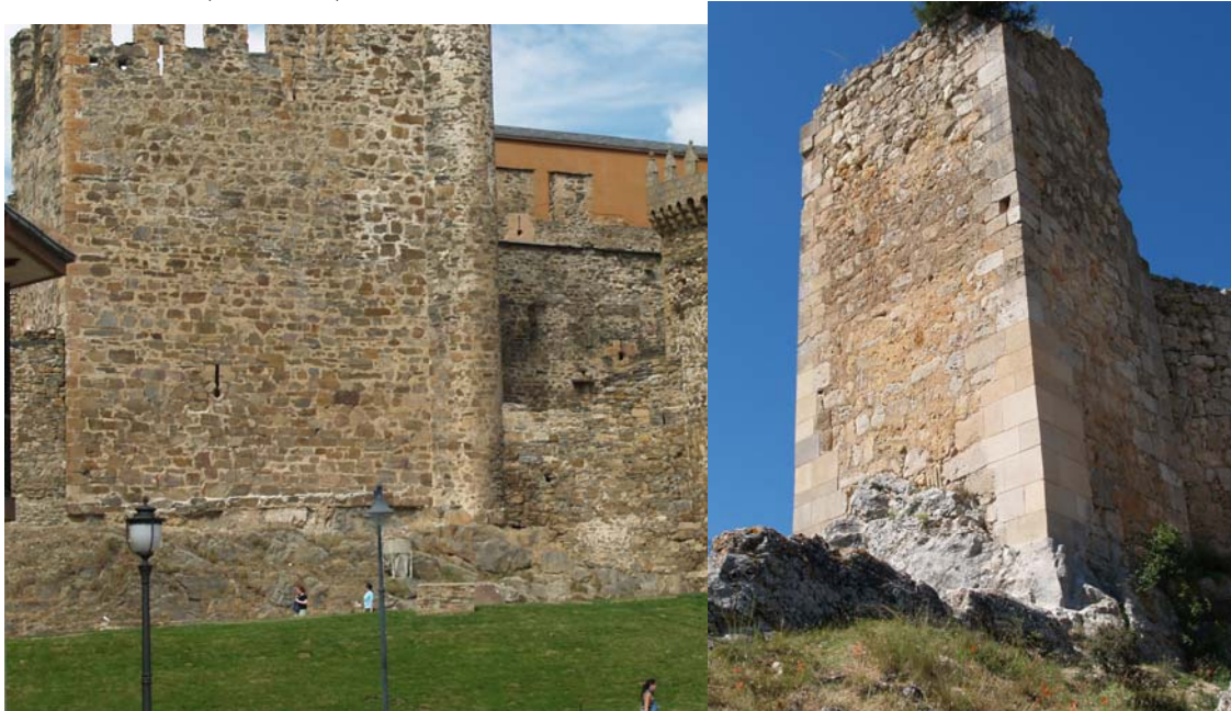
21. Recalce con peña falsa hecha con mortero bajo las torres de Ponferrada (león) y Osma (Soria).
