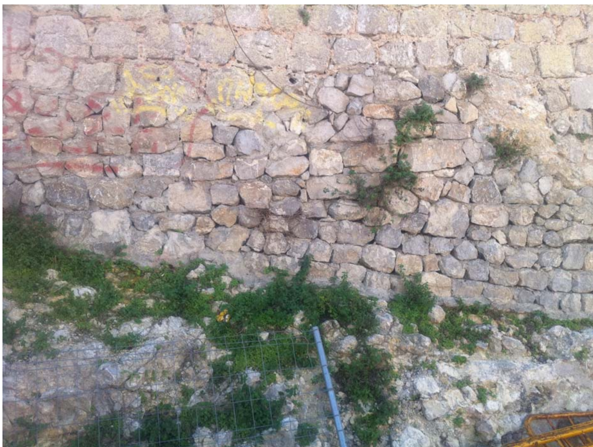
15. Cara del baluarte de santa Lucía. Hueco bajo basamento de piedra tapado con aparejo bastardo.
