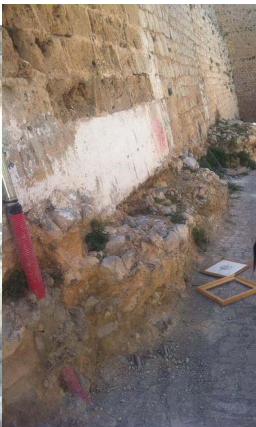
18 y 19 Flanco del baluarte de santa Lucía. Descalce de peña y cableado sobre restos de habitaciones púnicas
