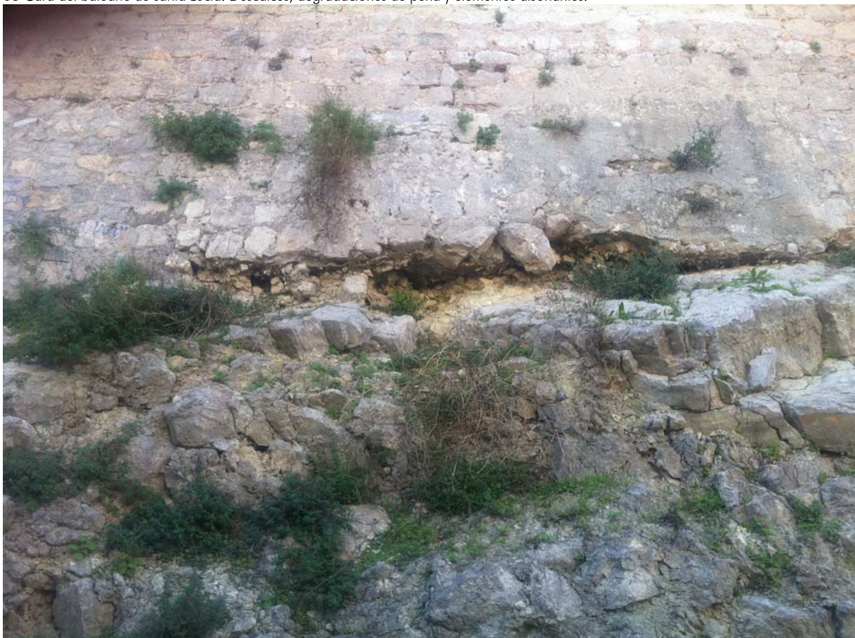
08 Cara del baluarte de santa Lucía. Descalces, degradaciones de peña y elementos disonantes.
