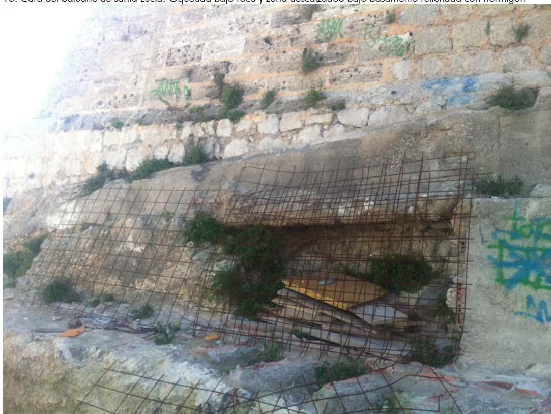
16. Cara del baluarte de santa Lucía. Oquedad bajo roca y zona descalzada bajo basamento rellena con hormigón
